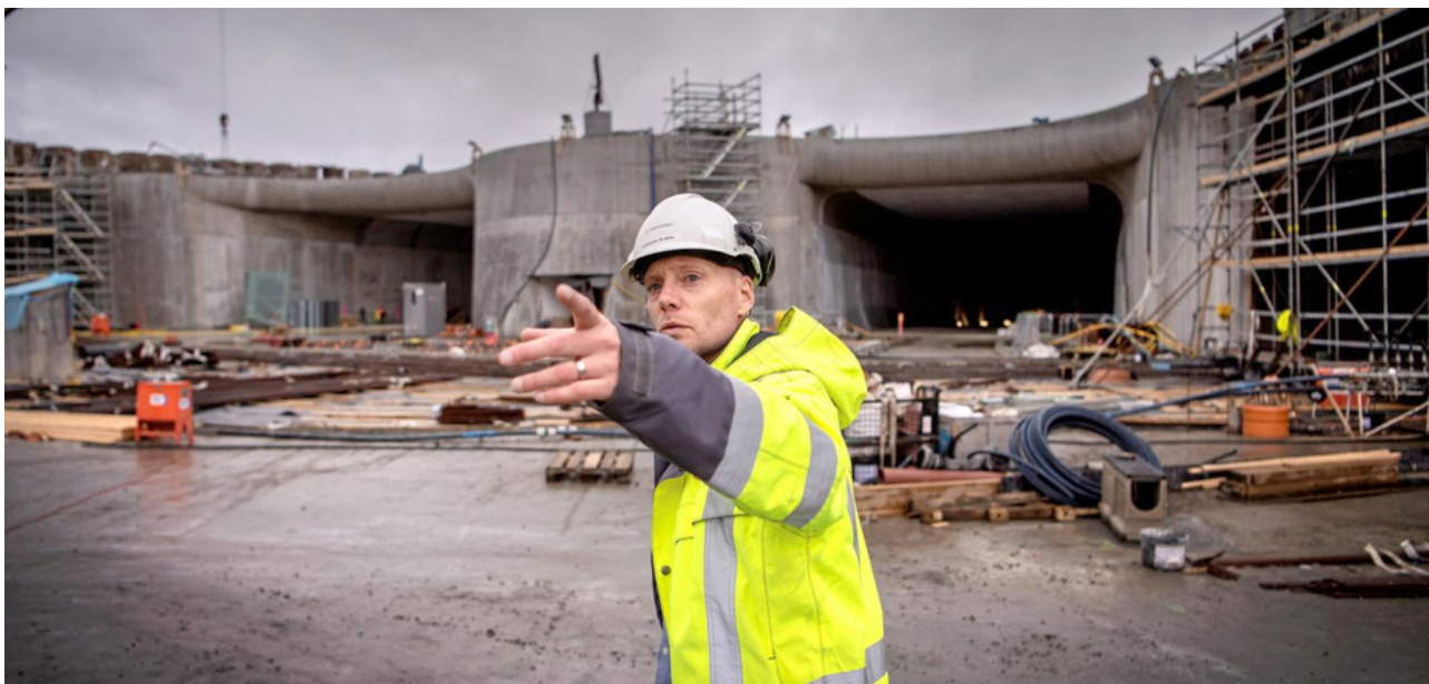
Johan Edin i rollen som entreprenadledare för Mariefholmstunneln
